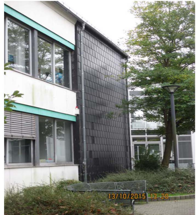
Fassadenplatten weiß (Asbest) Kunstschieferschindeln schwarz (Asbest)
