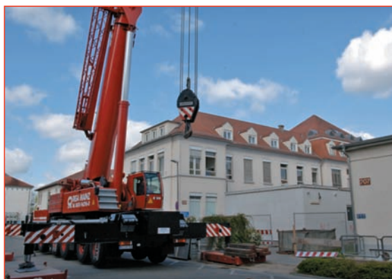
Установка блока для Chest Pain Unit, лето 2005 г.
