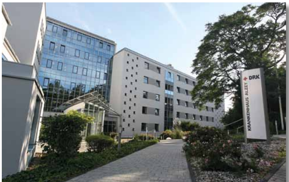
DRK Krankenhaus Alzey
