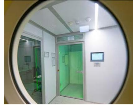
**Futuristischer Reinraum: Per Display lässt sich die komplexe Belüftungsanlage überwachen, Lichtsignale an den Türen stellen sicher, dass Luftdruck und Luftqualität konstant bleiben – hier ist alles im grünen Bereich.**
